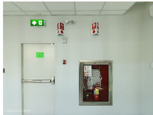
ตู้ FHC, ป้ายแสดงวิธีการใช้อุปกรณ์ดับเพลิง ไฟฉุกเฉิน กริ่งเตือนภัย ที่ติดตั้งเกิดเหตุเพลิงไหม้
