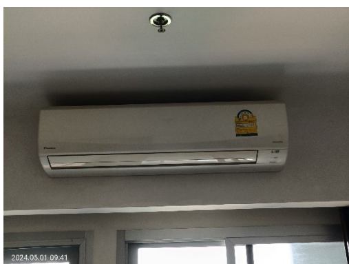
เครื่องปรับอากาศแบบแยกส่วน (Split Type)
